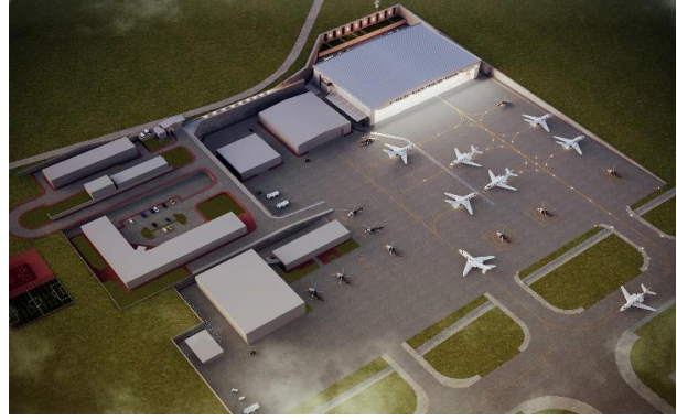
S.G. Hava Komutanlığı Uçak Hangarı İnşaatı Menderes/İZMİR
