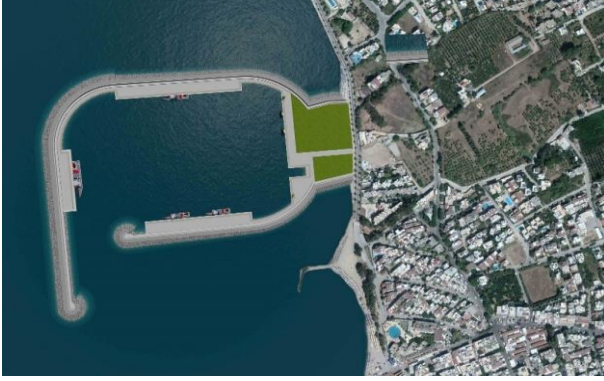
Bodrum Turgutreis Liman İnşaatı Bodrum/MUĞLA
