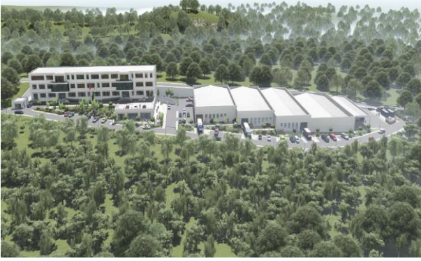
İkmal Destek K.lığı ve EKM K.lığı İnşaatı Gaziemir/İZMİR
