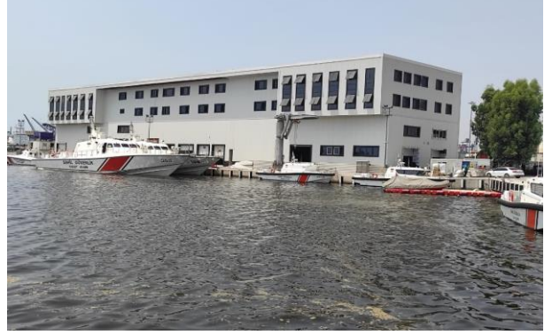
Akdeniz Onarım Destek K.lığı İnşaatı Akdeniz/MERSİN
