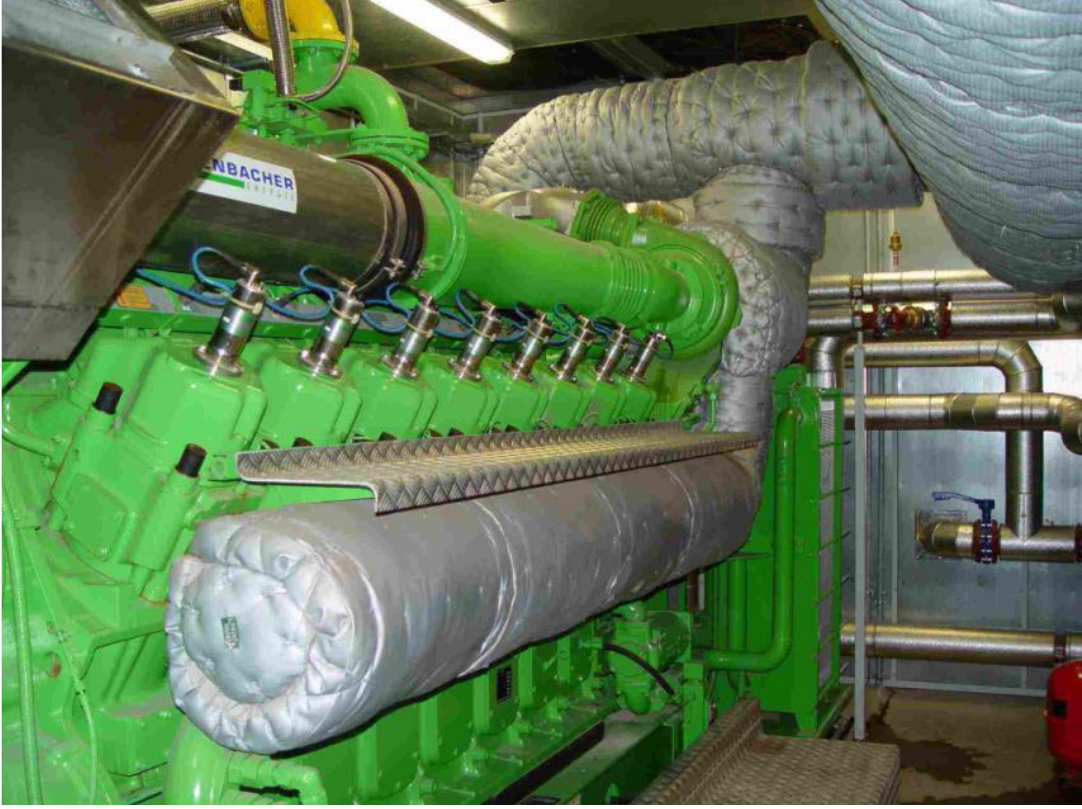
Őekil 3-17 : Egzoz manifoldu ve borularının yalıtılması
