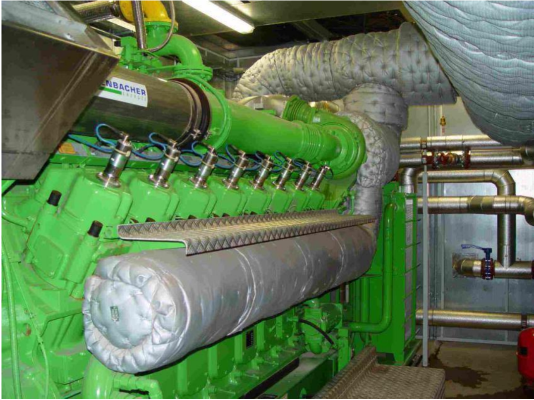
Şekil 3-17 : Egzoz manifoldu ve borularının yalıtılması
