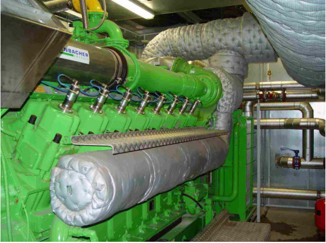
Őekil 3-17 : Egzoz manifoldu ve borularının yalıtılması
